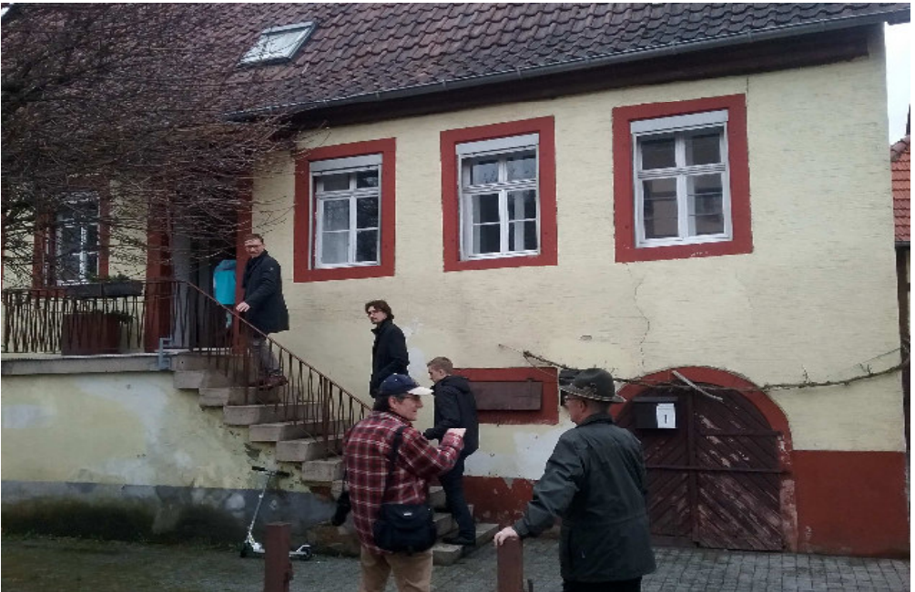
Rundgang mit Wolfgang Krauß, hier vor dem Gebäude von Christliche Dienste und DMFK
